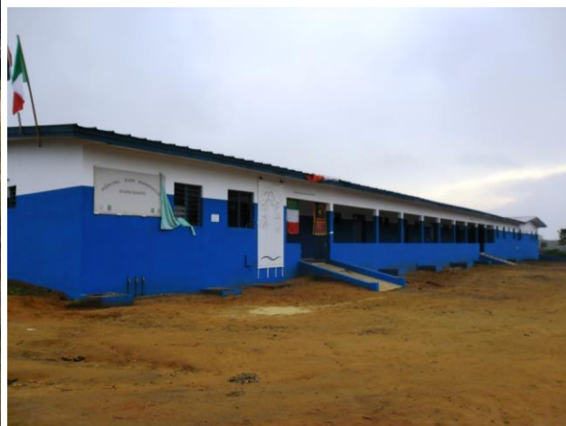
2 ème Bâtiment du CMSSBO
